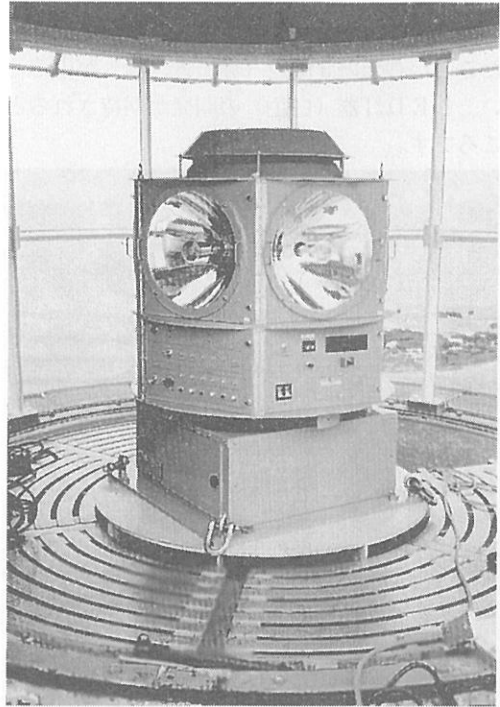
写真5 メタルハライドランプを使用したLU-M型灯器（ユニット式の回転灯器） 稲穂岬灯台（第一管区）
