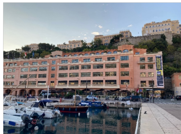
写真3 現在の建物(5階に事務局があります)
